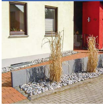
Hauseingang nachher: mit Rampe
