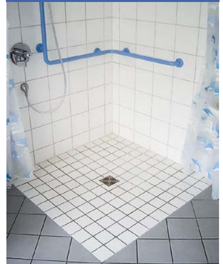
Dusche nachher: ebenerdig
