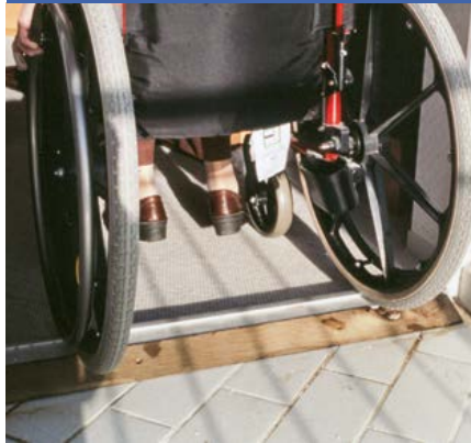
Schwellenbrett zum Ausgleich der Türschwelle
