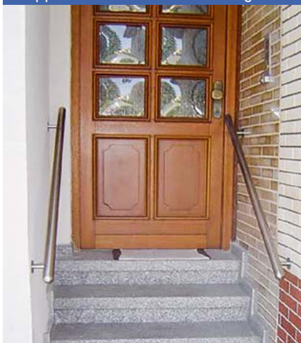
Treppe mit Handläufen beidseitig
