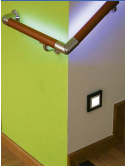
Beleuchteter Handlauf und Orientierungslicht
