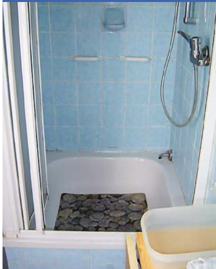
Dusche vorher: mit hohem Einstieg
